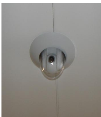
Figura 5. Detalle de una de las cámaras PTZ situada en el techo del vestíbulo de la Escuela.
